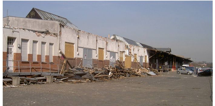
Vorerst gestoppter Abriss der Güterhallen
