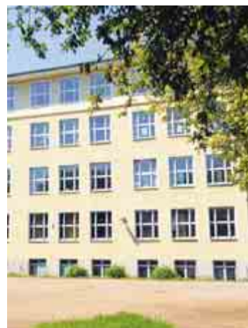
Das Schulgebäude an der Hachenburger Straße BILD: RAMME
