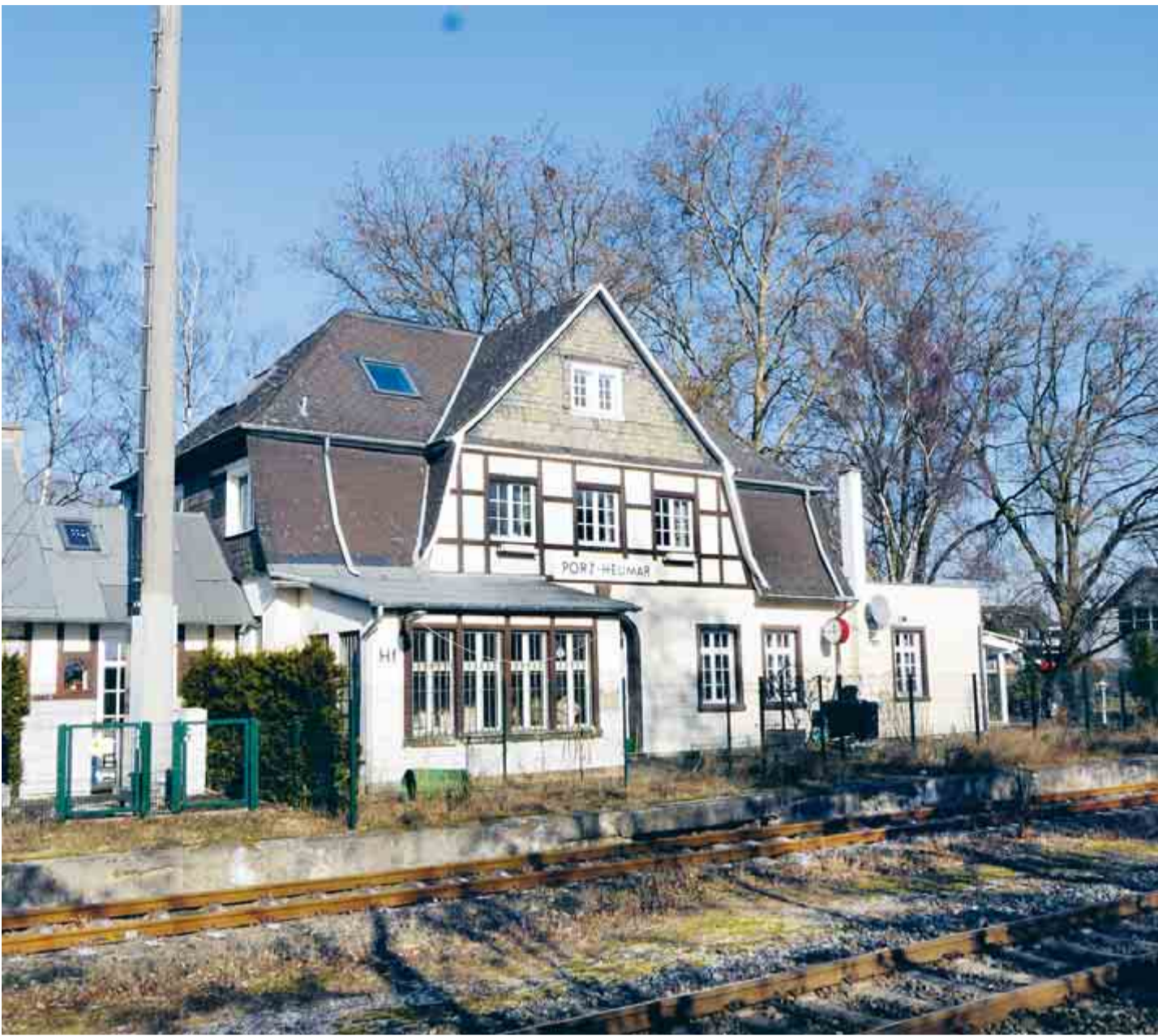
Im Bereich der Eiler Straße in Rath-Heumar soll eine neue Bushaltestelle entstehen. Der ehemalige Bahnhof könnte sich eignen. BILDER: RAMME
